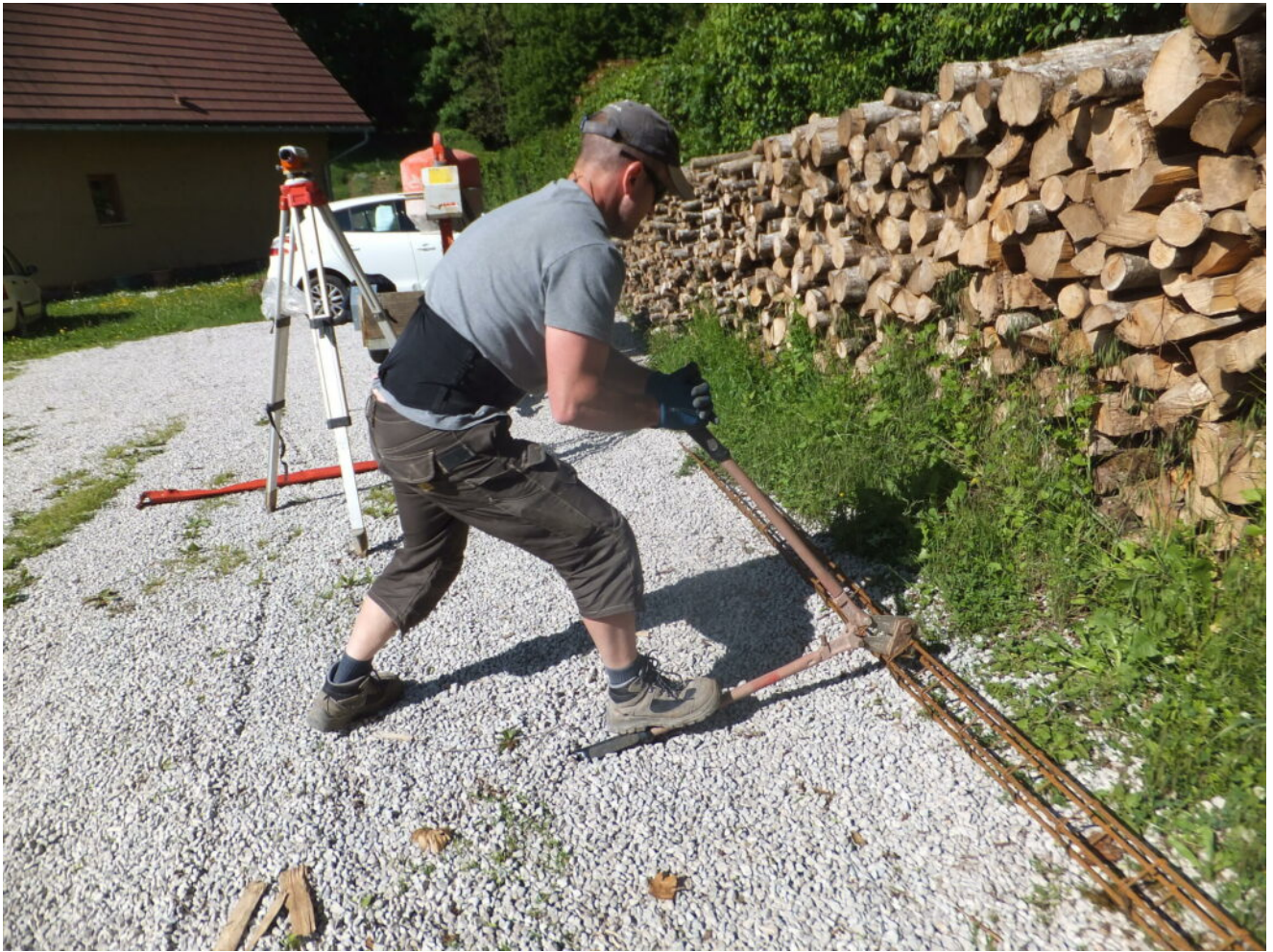
montage du pieds de poteau
