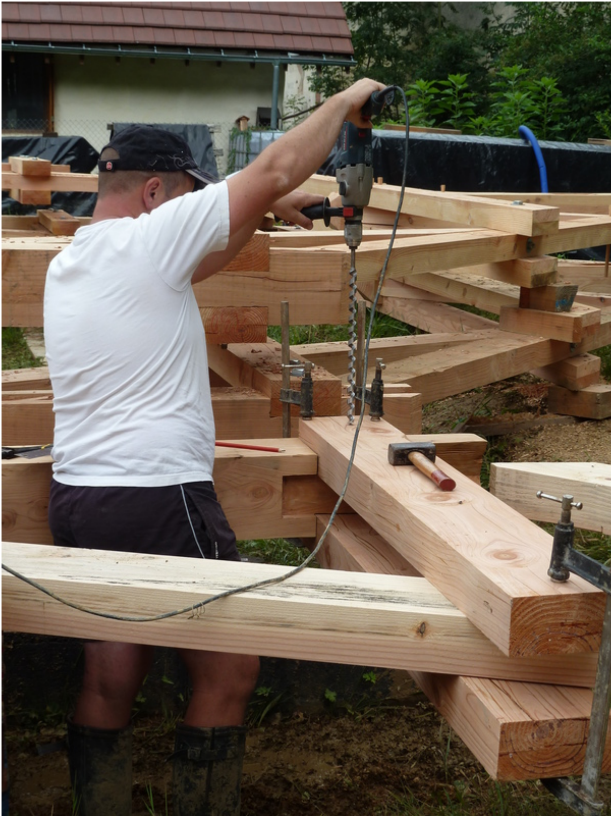
mise en place du poinçon et des arbalétriers...
