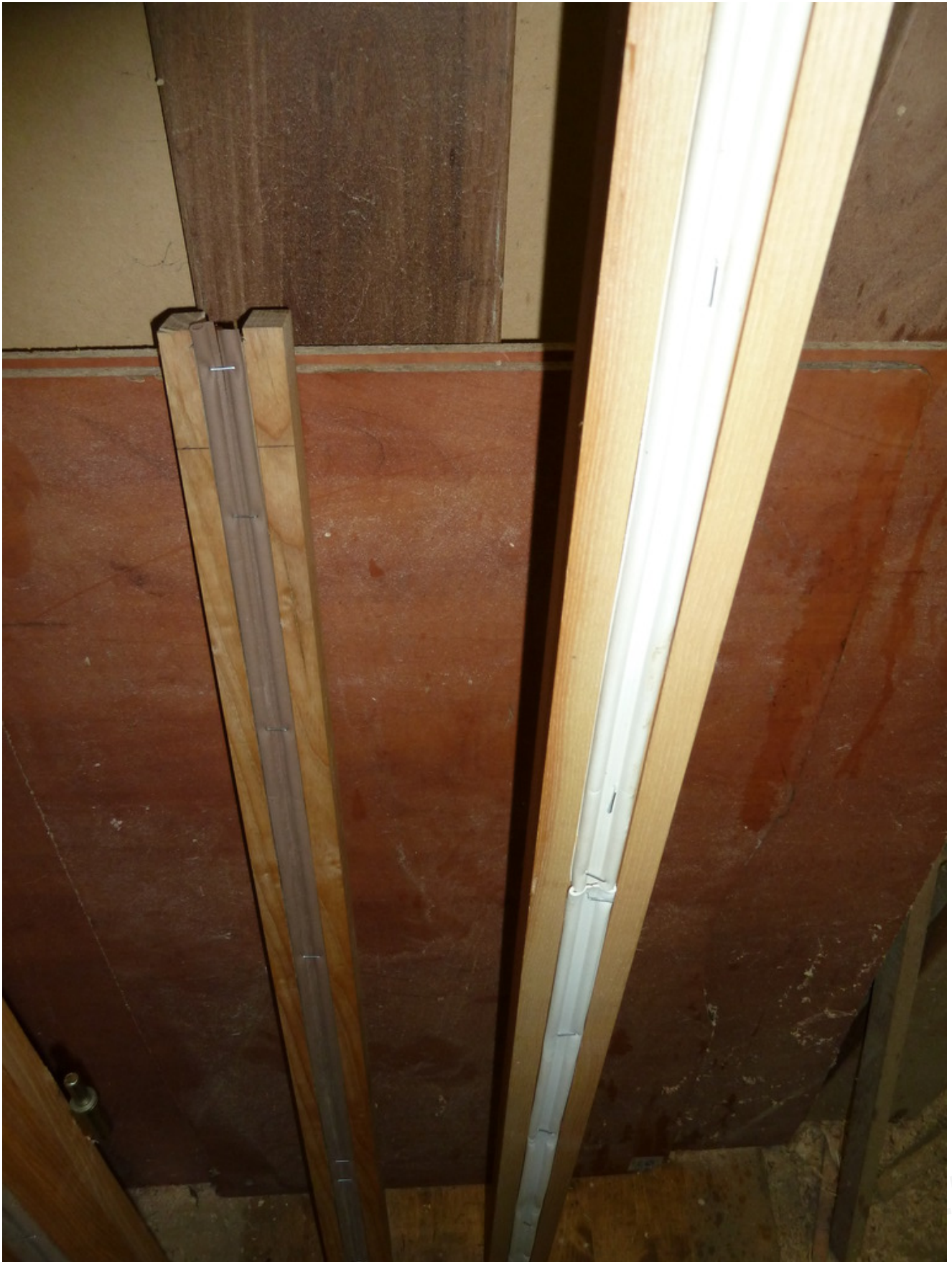
les pare closes extérieur et le pied de poteau droite en chêne de recup' en attente de se faire insectiser.
