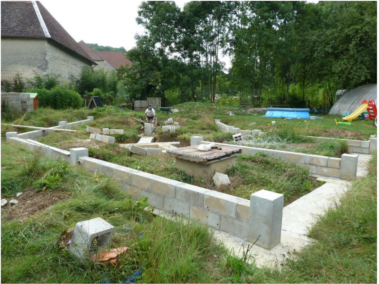
la dalle du poêle de masse.
