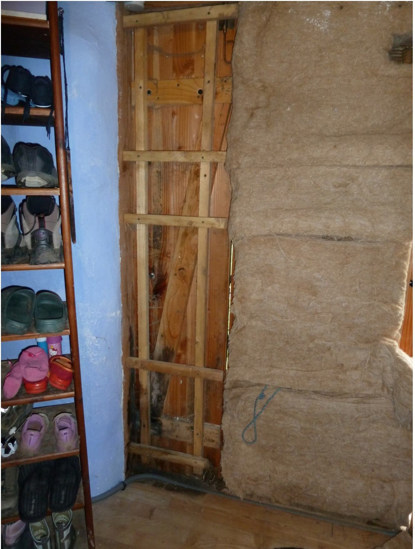
mise en place du poteau en chêne qui servira d'appui au dormant.
