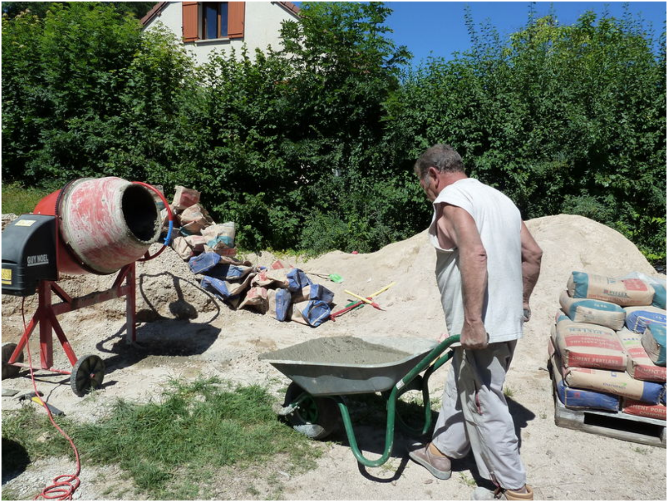
Isabelle a l'étalage du béton.
