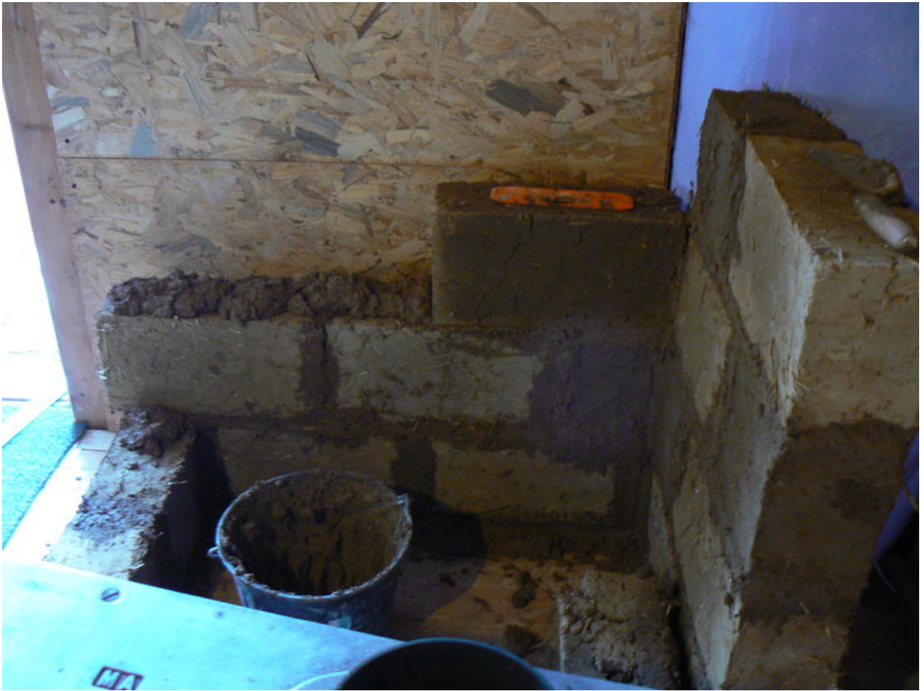
Recoupage d'un parpaing au couteau a pain.
