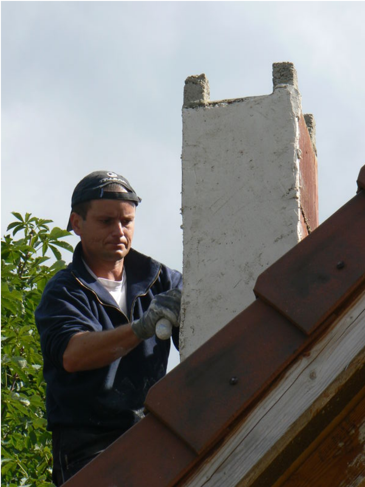
Scellage de la trappe de ramonage
