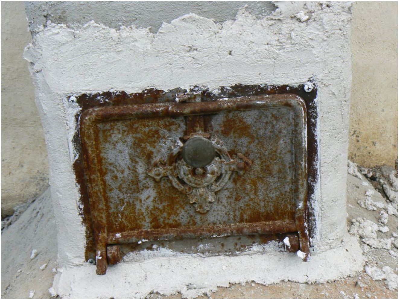
Et bouchage du toyo de conduit de cheminée
