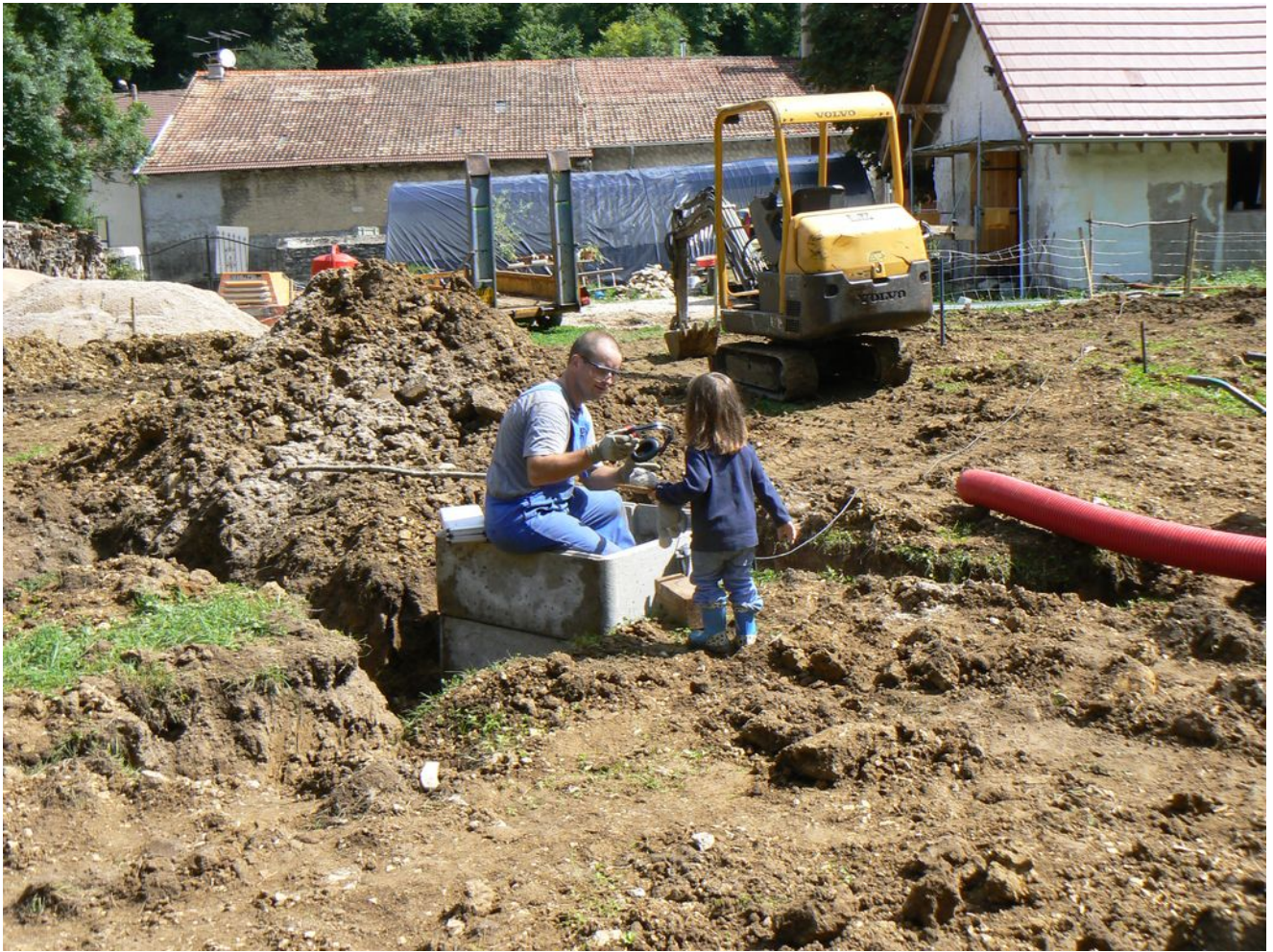
Perçage du trou pour passer la gaine du puits canadien
