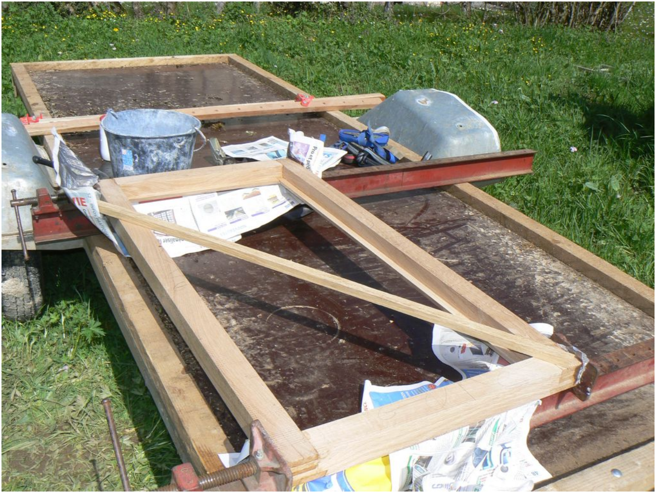
Les deux ouvrant, la gueule de loup ( pièce centrale ) et le début des traverses du bâti
