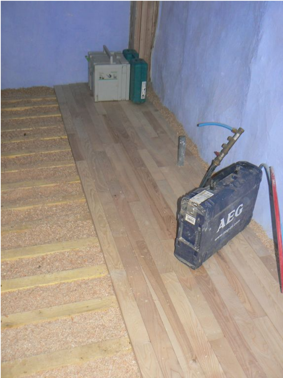
Le résultat après ponçage et sa première couche d'huile.
