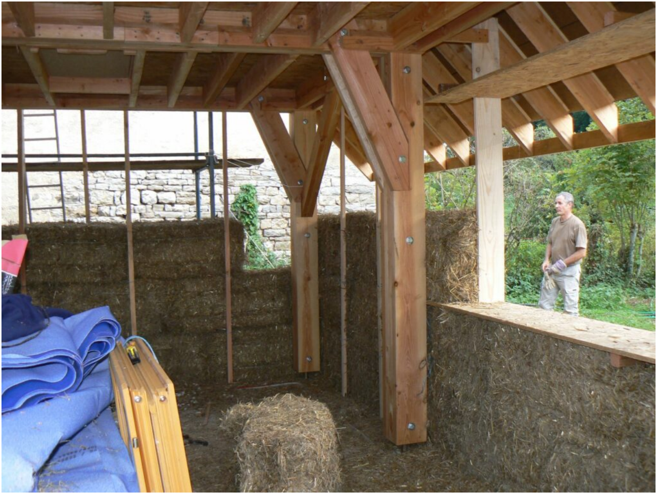
Préparation avec Maurice de « l'ossature » pour la porte de garage
