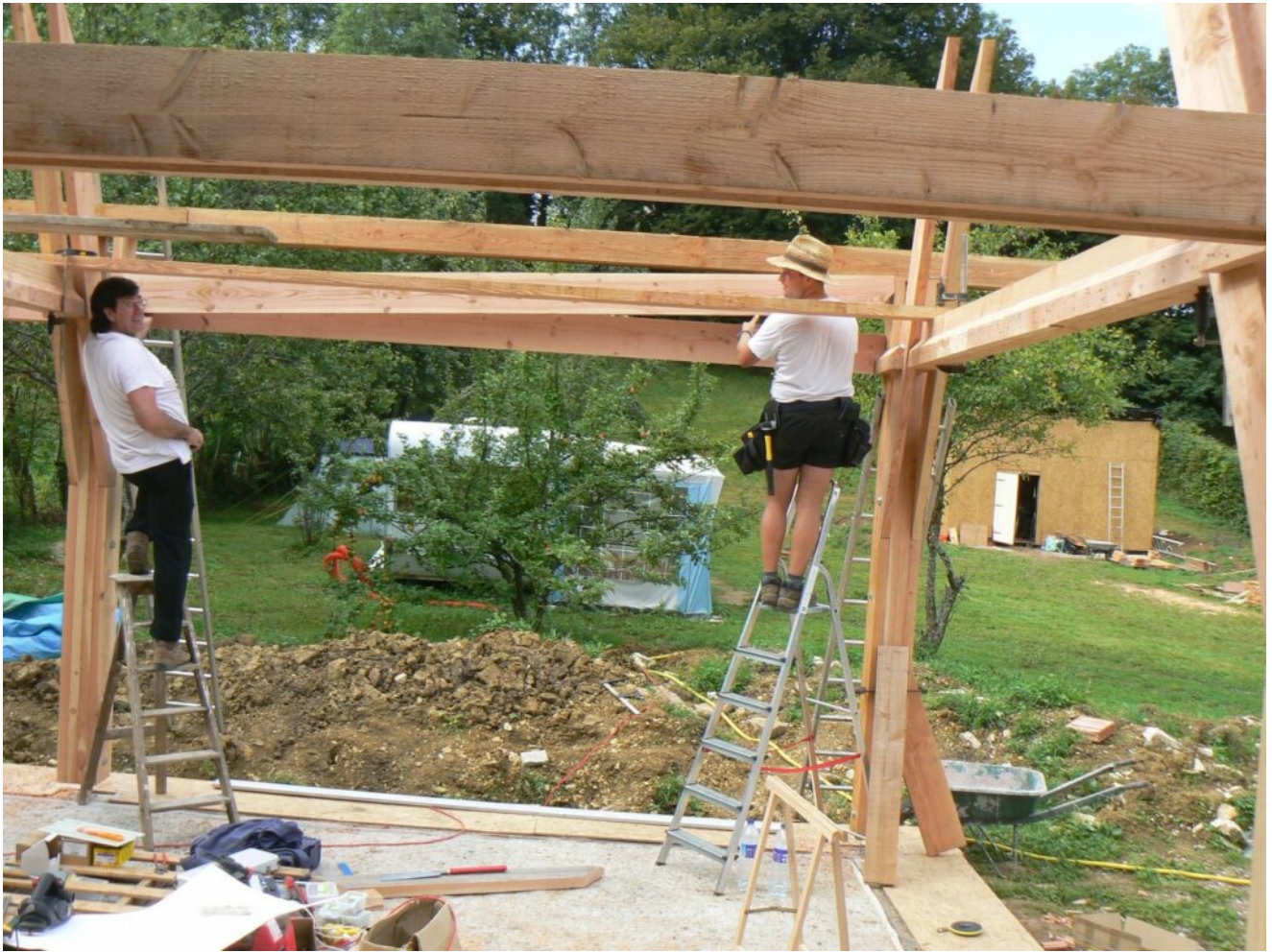
Sur cette photo, on voit bien déjà, le « sandwich » de planche et la jonction des fermes et du plancher.
