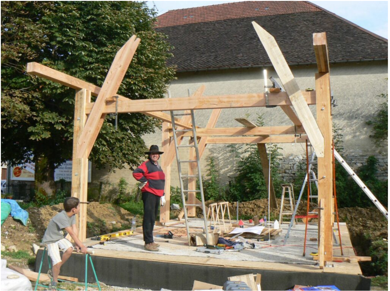
La jonction des deux morceaux de panne sablière.
